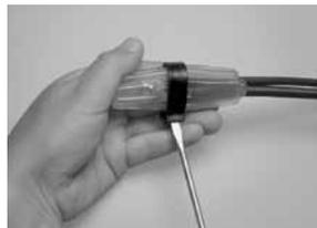
④ 打开固定夹，稍转动端套
