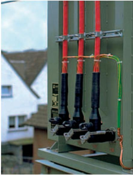
肘型端头用于户外SF<sub>6</sub>变压器
