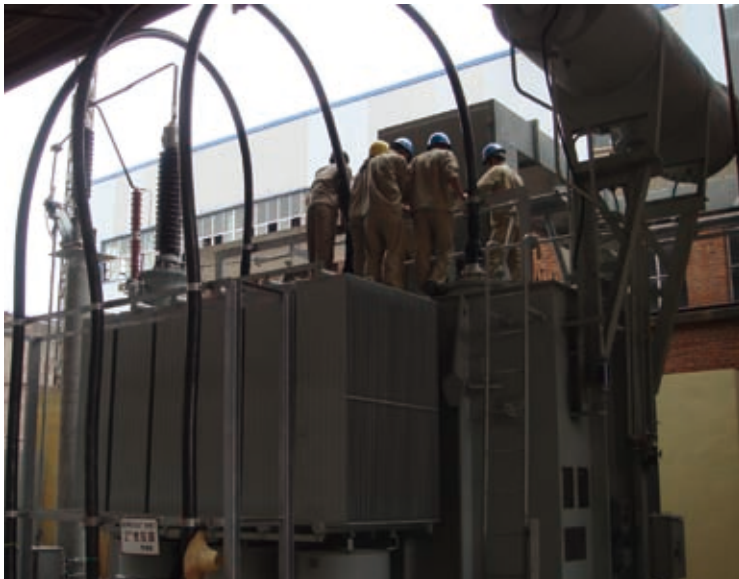
110kV变压器终端安装在武钢
