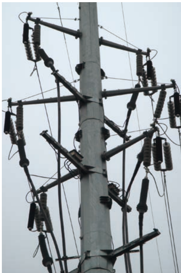
110kV柔性终端安装在武钢
