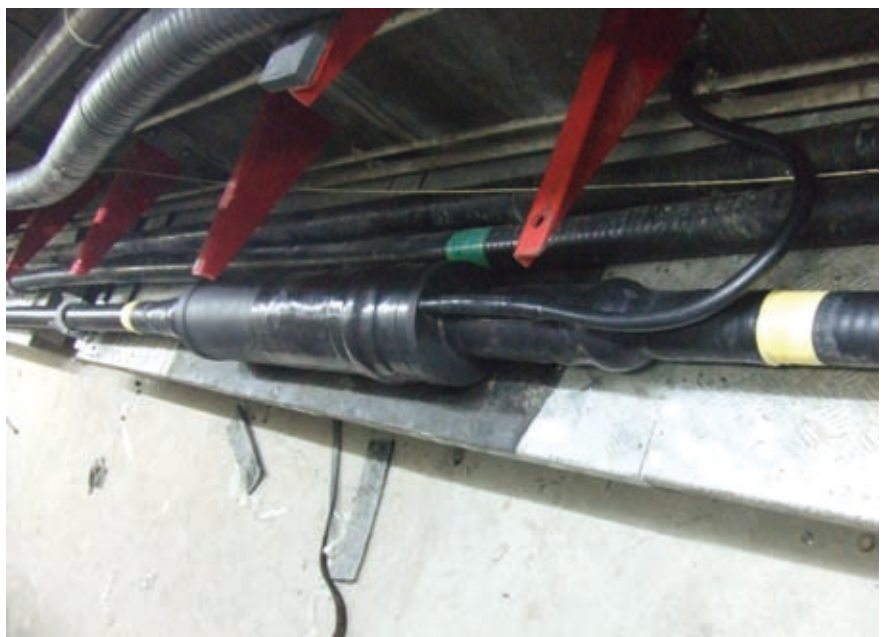
110kV中间接头安装在广州供电局
