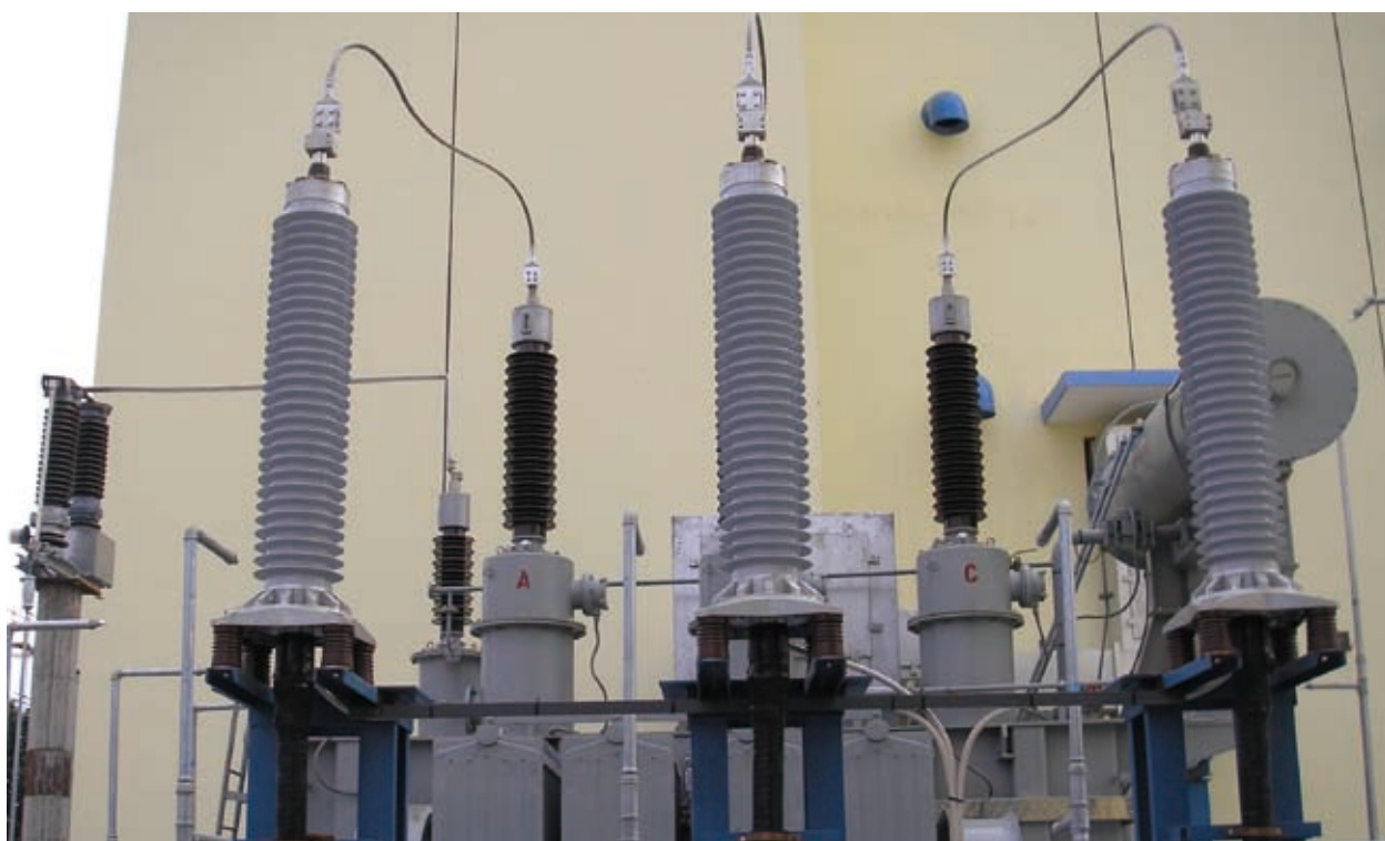
110kV复合套管OHVT安装在广州石化
